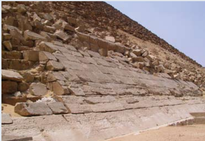
Une partie du revêtement de la pyramide « Rouge » située à Dashour et édifiée par le pharaon Snéfrou, père de Khéops, pour édifier ce tombeau de forme pyramidale.
