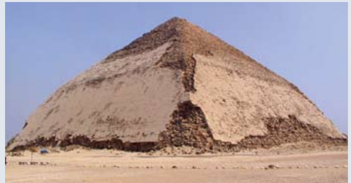
Revêtement de la pyramide « Rhomboïdale » édifiée par le pharaon Snéfrou : les traces du revêtement sont très visibles encore de nos jours sur ce tombeau de forme pyramidale.
