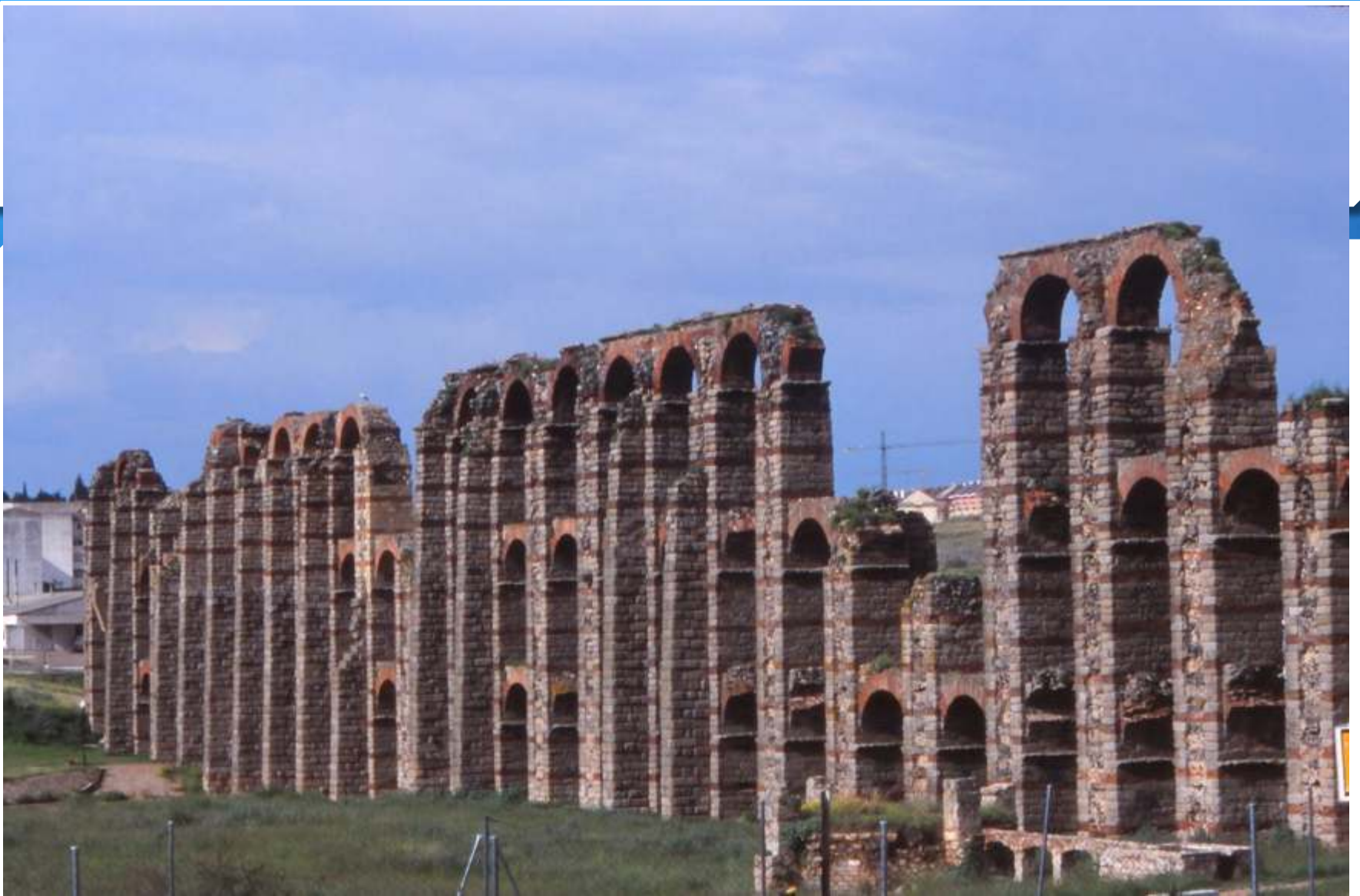
Aqueduc de Mérida (Espagne). Cliché: Luc Guay
